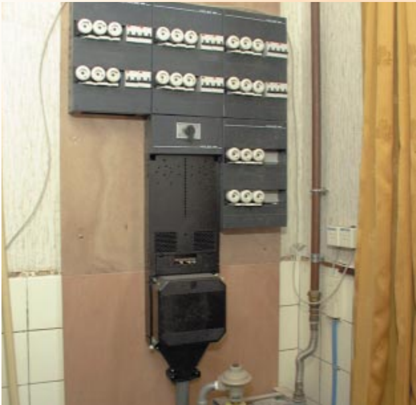
Toepassing van een Duco-hoofdschakelaar 63 A in laagspanningsverdeelstelsel Systeem 55.
